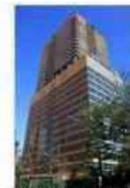
赤坂インターシティ(2005年竣工) 基調色・タイル 2.5Y 6/6
