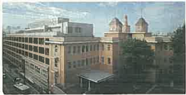
修繕事例 聖母病院
