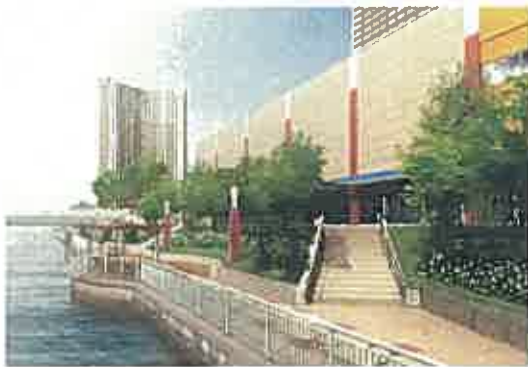
一体的に整備された護岸の遊歩道
