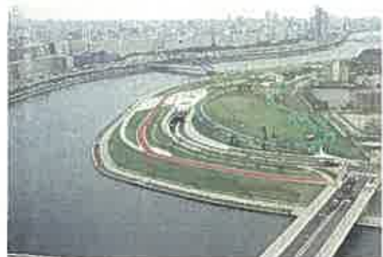
公園・スーパー堤防・道路の一体整備
