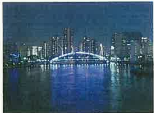
隅田川橋梁のライトアップ
