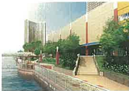
一体的に整備された護岸の遊歩道
