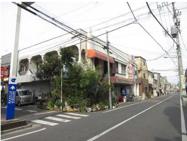
補 285 が南に屈曲していく街区(南東より見る)(南小岩 4-4 街区)
