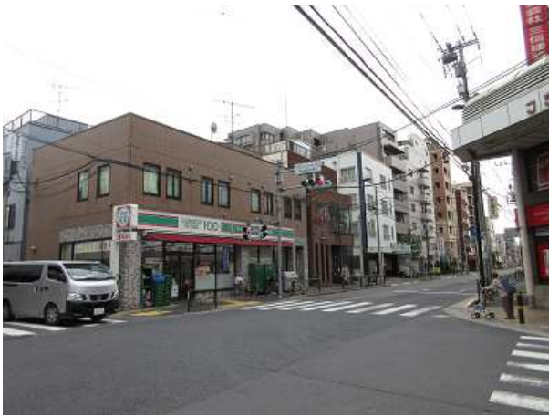
路事業中の千葉街道(補 142)と事業予定の補 285 交差点を北東より見る(南小岩 4-13 街区)
