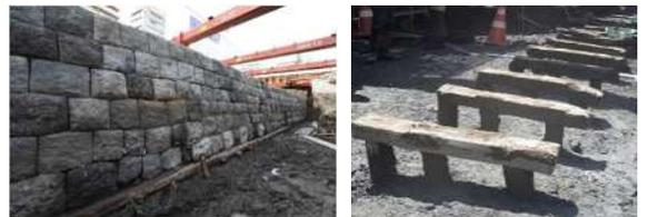
写真6 明治時代の石積護岸（左）と護岸下の枕木・杭岸（右）
