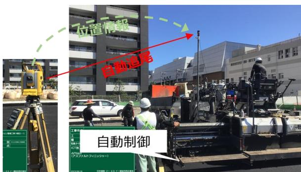
写真 7 MC アスファルトフィニッシャー
