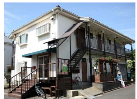
<空き家等地域貢献活用「タガヤセ大蔵」> (世田谷区)
