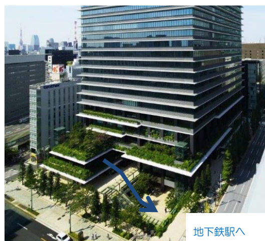
<地下駅前広場の整備例> (中央区 京橋東京スクエアガーデン)
