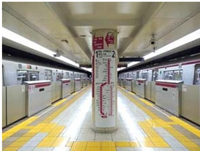
<ホームドアの設置>
