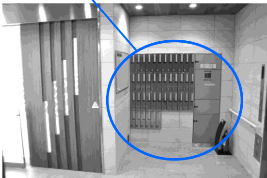
玄関付近に郵便受け、宅配ボックス設置
