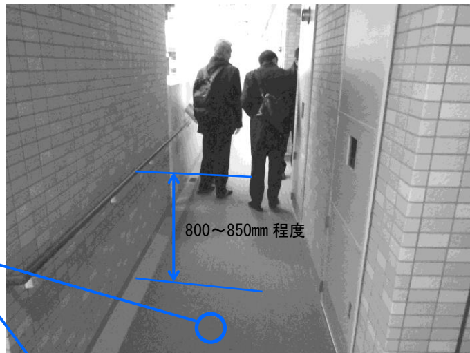
手すりの設置例-1
