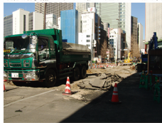
② 既設舗装撤去状況(桜田通り交差点部)
