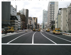
④ 車道舗装状況(第一京浜交差点部)
