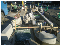
① 歩行者横断部ブロック設置状況(外堀通り)
