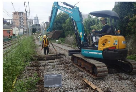
撤去工（マクラギ）
