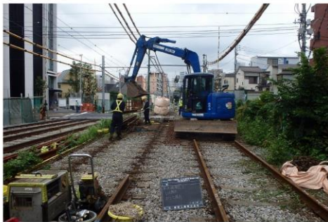
撤去工（レール）
