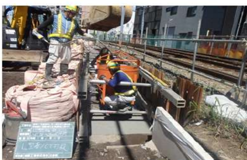
基礎コンクリート設置
