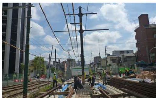
センターポール設置（施工中）
