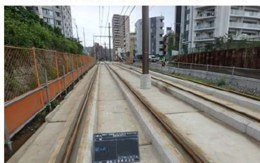
インファンド軌道設置（施工後）
