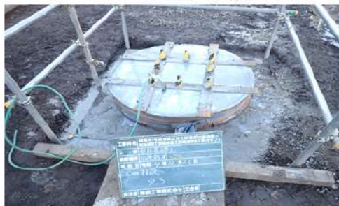
センターポール基礎設置完了
