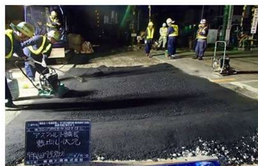
切替部舗装（踏切部）
