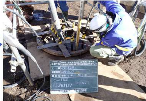
コンクリート打設
