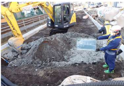
・路床改良材料攪拌作業
