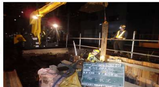
仮設材（山留）設置
