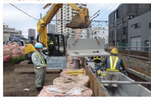
L型擁壁設置
