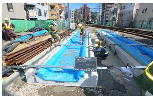
インファンド軌道設置（施工中）
