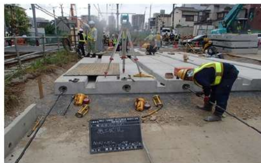
連接軌道設置【踏切部】（施工中）
