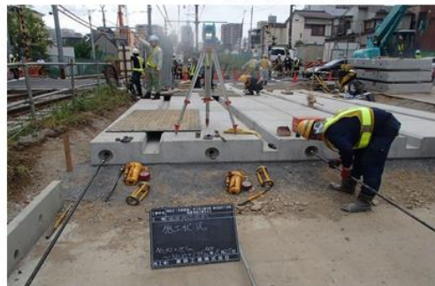
接続軌道設置【踏切部】（施工中）
