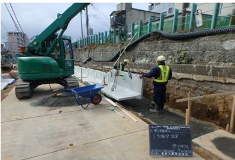
L型擁壁設置（施工中）
