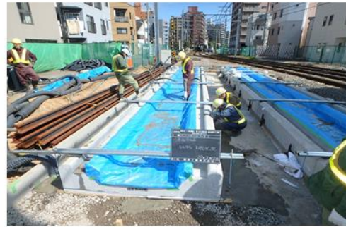
インファンド軌道設置（施工）
