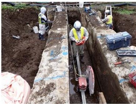
構造物切断状況
