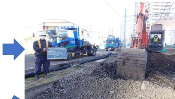
・ 碎石撤去状況
