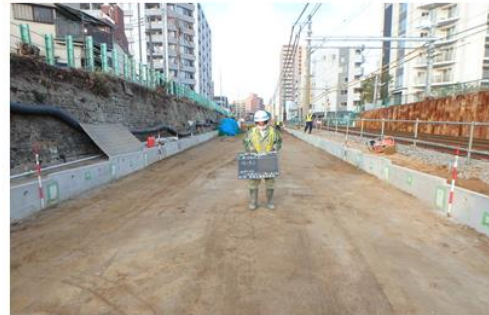
L型擁壁設置（施工後）
