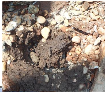
基礎杭（松杭）の頭頂部分
