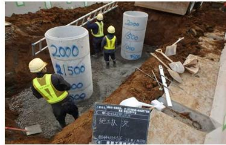
センターポール基礎設置（施工中）
