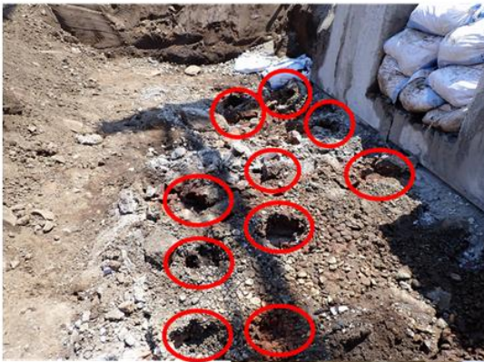
埋設構造物撤去後の基礎部
