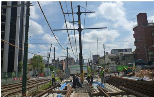
センターポール設置（施工中）
