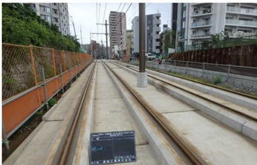
インファンド軌道設置（施工後）
