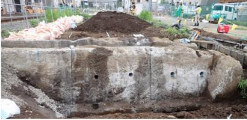
①切断後状況
