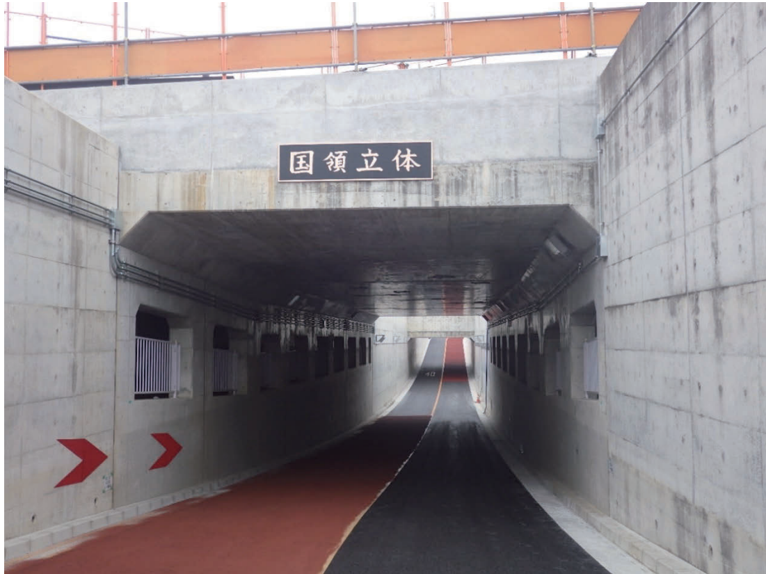
【京王線交差部北側付近】
