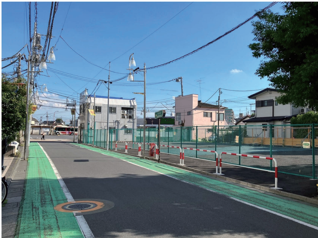
【上石神井駅南側千川通り付近（暫定歩道設置状況）】
