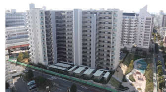
最後の整備街区 PE30 (R4.1.27 建築工事了)
