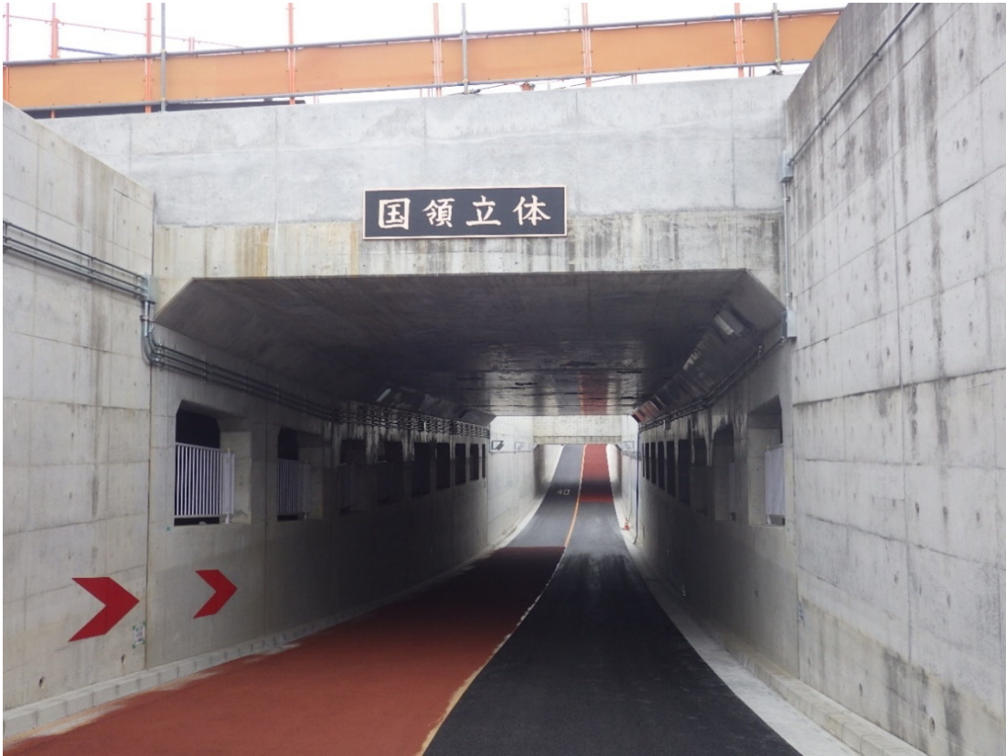
【京王線交差部北側付近】
