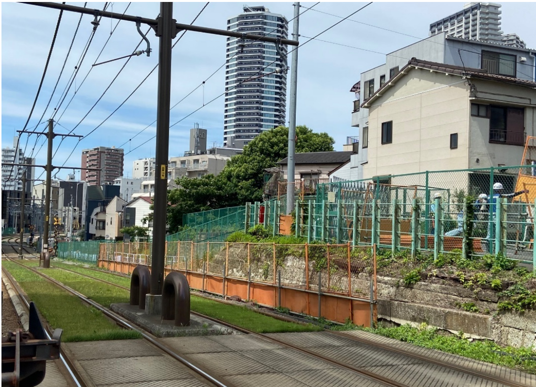
【軌道緑化（坂下通り付近）】 奥にB街区(令和4年3月竣工)を望む
