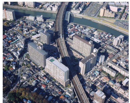
赤羽北地区市街地再開発事業完成写真
