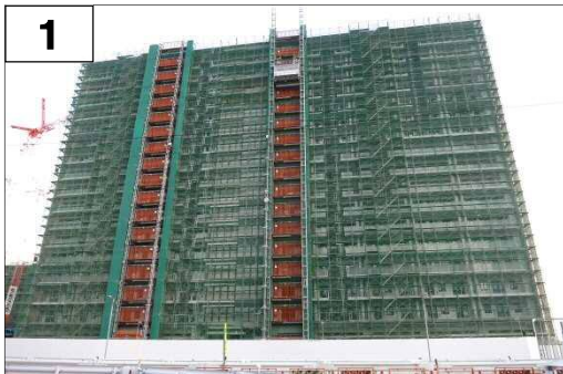
1 5-3街区 A棟 くたい 躯体工事了
