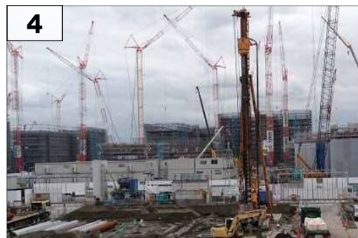
4 5-7街区 基礎杭 くたい の施工状況
