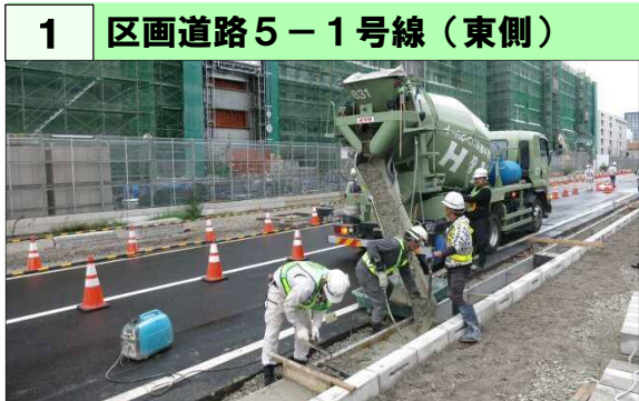
1 区画道路5-1号線（東側） 歩車道境に排水施設「街きよ」を設置しています。
