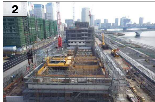
2 5-4街区 C棟 くたい 地上躯体の整備状況
