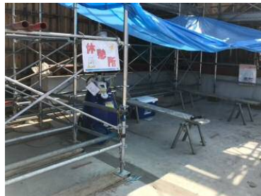
簡易休憩所の設置
