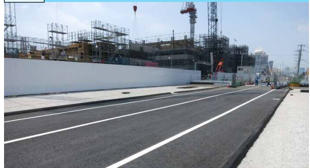
仮舗装が完成しました。《 詳細はP5を参照 》
