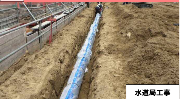
もりど 道路盛土にあわせて、水道管を新設しています。
