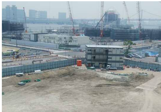
5-7 街区 現場事務所・フェンスの設置完了
