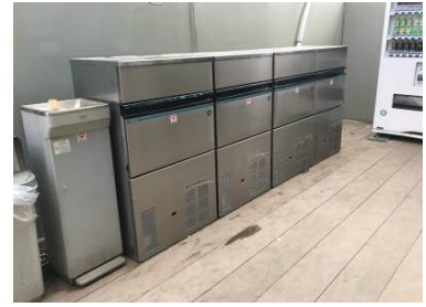
製氷機の設置
