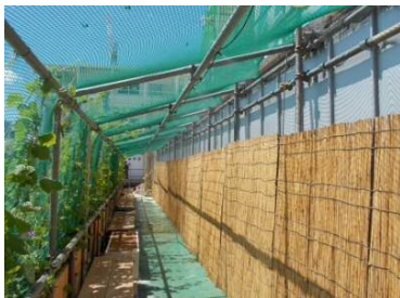
植物による日陰の創出 (作業員通路)
