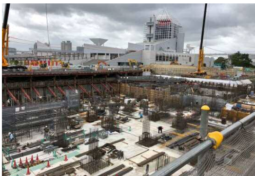
5-6 街区 地下躯体の整備状況
