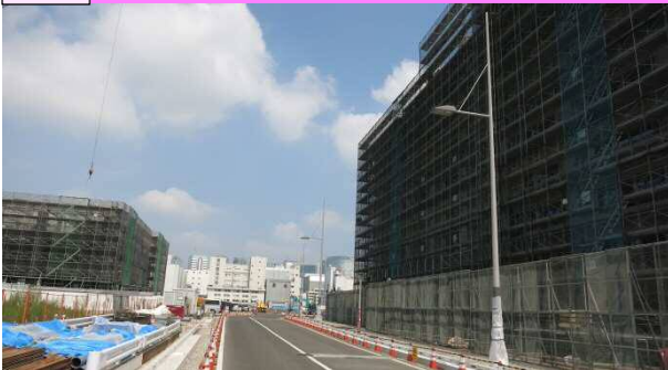
街区側で道路照明の設置が完了しました。
