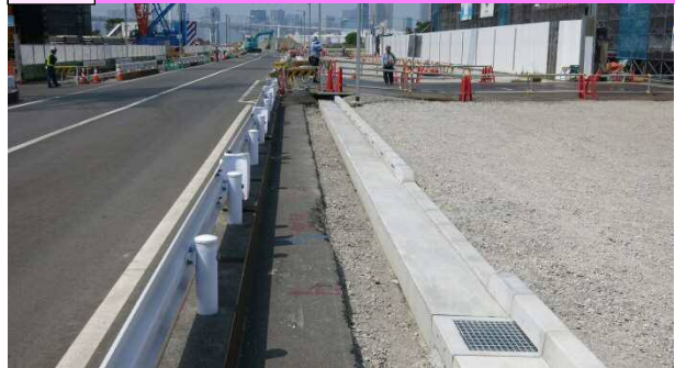
車道と歩道との境に設置される排水施設「 がい 街きよ」を設置しています。
