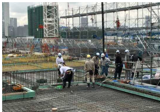
5-5 街区 コンクリートの打設状況
