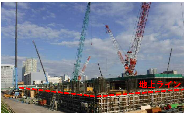
建築躯体の整備状況（5-3街区）
