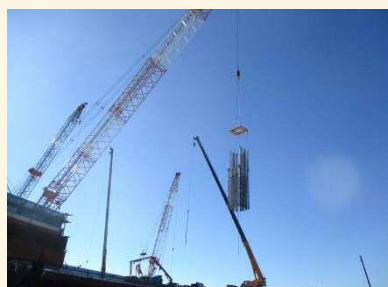
クレーンによる運搬
