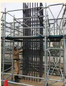
地上での鉄筋組立て
