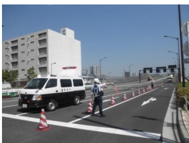
工事車両の誘導
