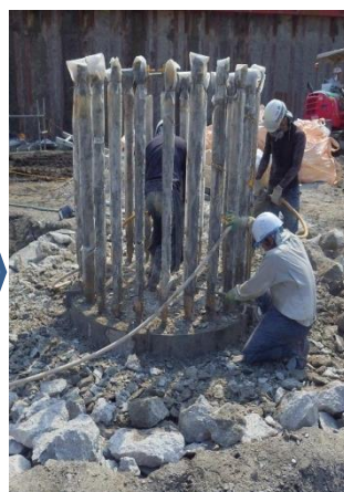
② 杭頭処理の状況
