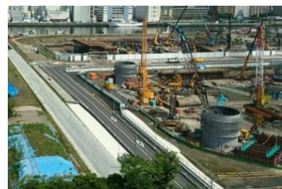
④切替え後の道路を望む (晴海客船ターミナルより)
