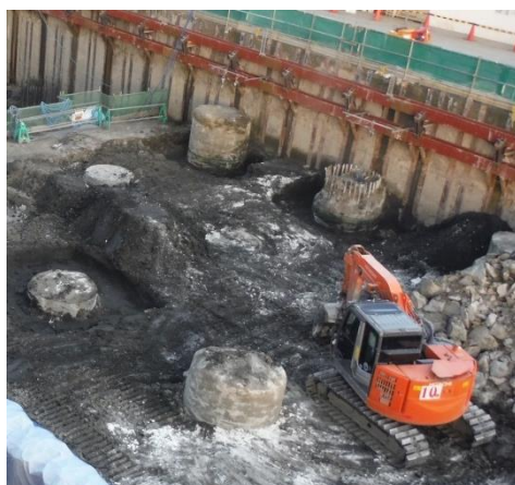
① 掘削の状況
