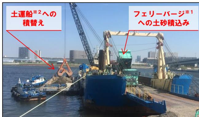
③ フェリーバージ※1への土砂積込み、土運船※2への積替え状況
