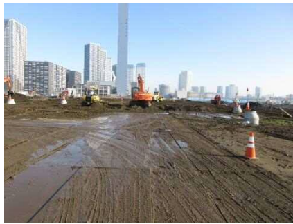
道路の盛土工事をしています （5-3号線）
