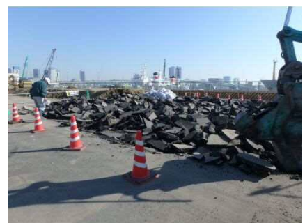
舗装などを撤去しています （5-1号線）
