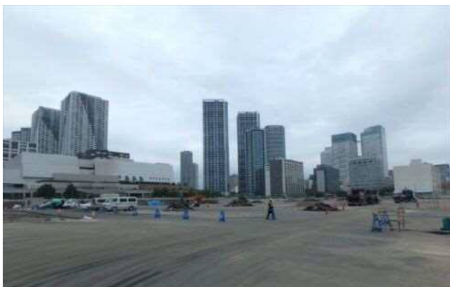
解体工事着手前状況 (10月初旬)
