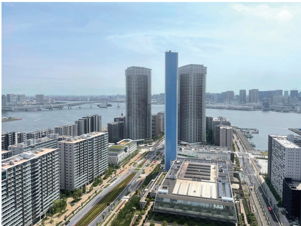
施行地区現況 令和7年5月 撮影
