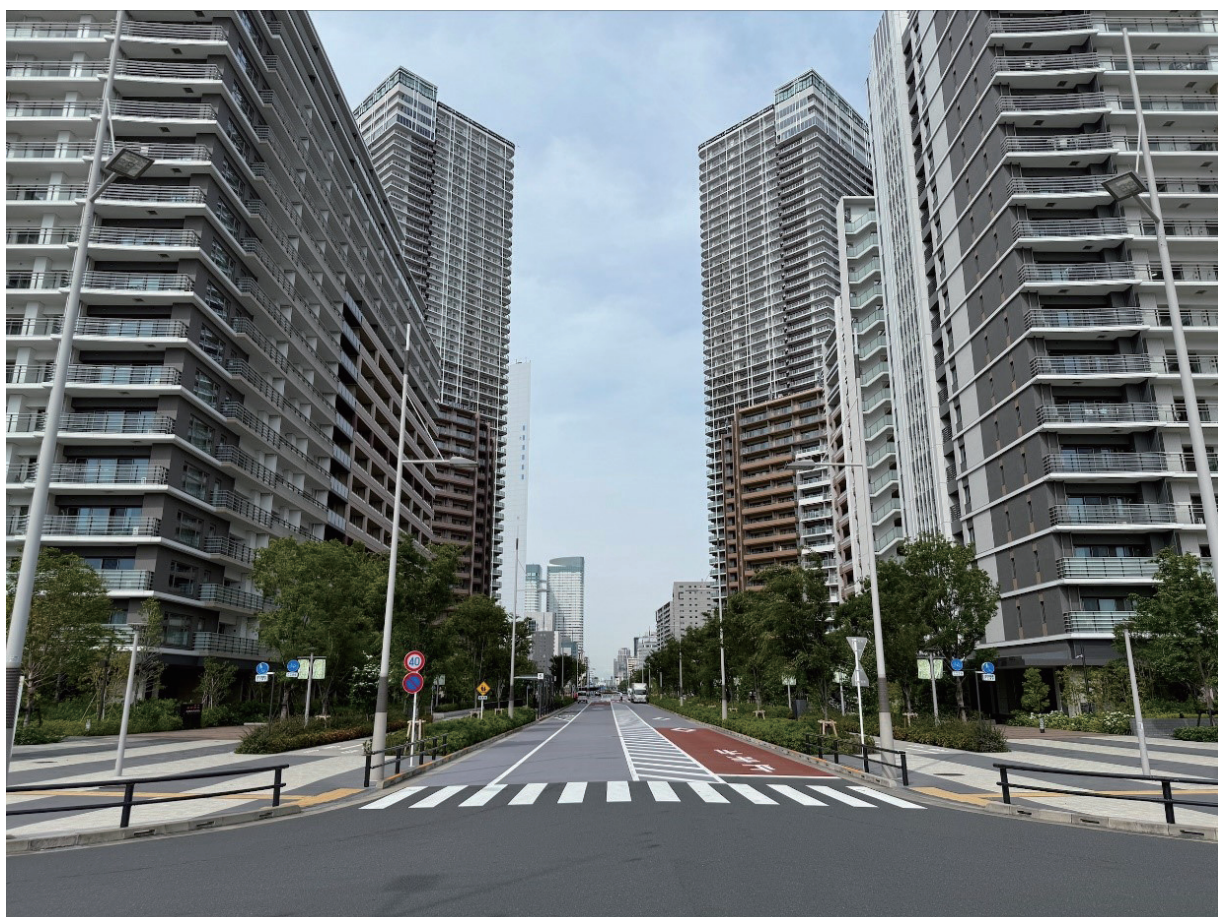
施行地区現況 令和7年5月 撮影
