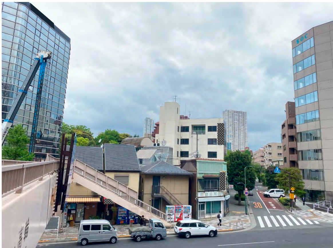
環四高輪地区（起点側）
