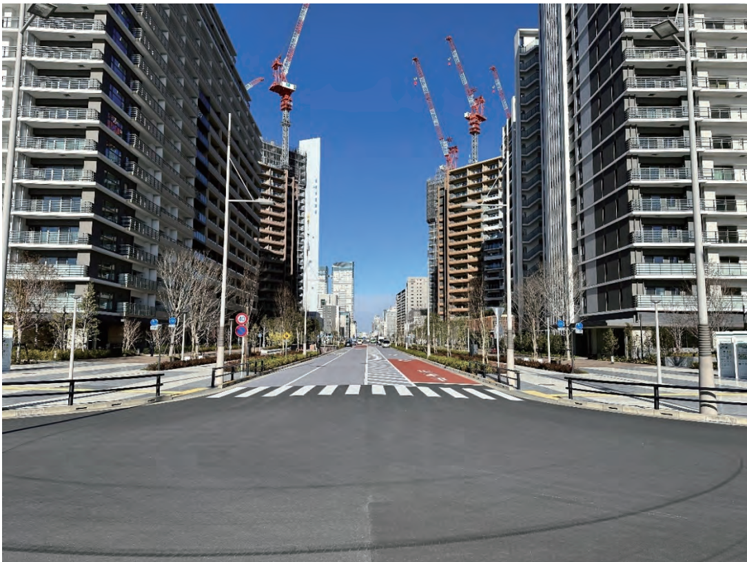
施行地区現況 令和6年2月 撮影
