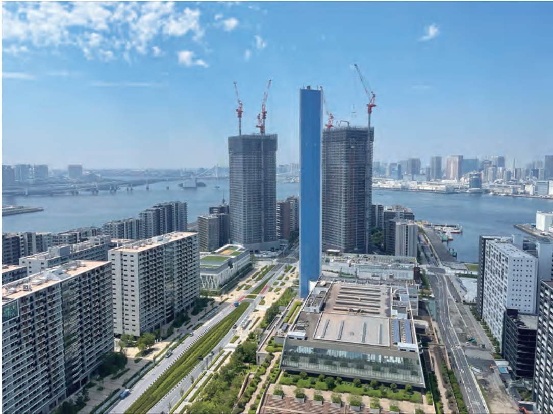
施行地区現況 令和6年7月 撮影
