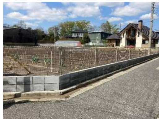
土留め、フェンス
