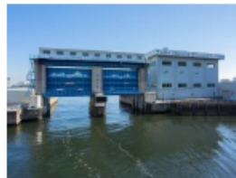
芝浦排水機場
