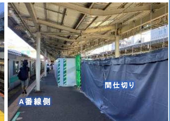
日中作業時 (間仕切り等で作業範囲と お客さま動線を分離)
