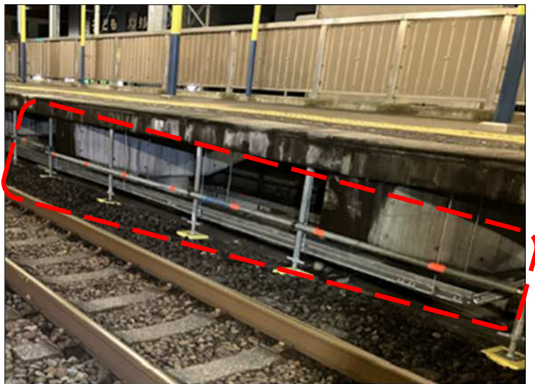
仮設昇降ステップ設置状況
