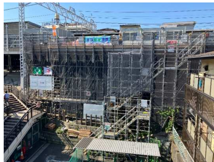
【東武練馬駅 施工ヤード参考写真】
