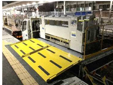
軌陸車による運搬
