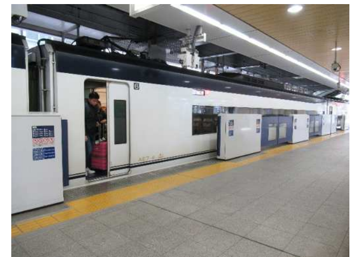
②大開口ホームドア開閉時
