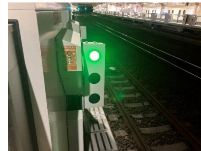
工法見直しによる工期短縮の例：ホームドア表示灯の筐体内蔵化
