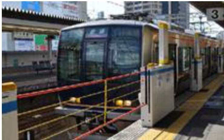
昇降ロープ式ホーム柵(JR西 六甲道駅)
