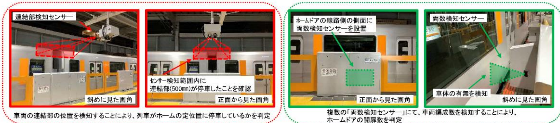
【連結部検知センサーの詳細】
