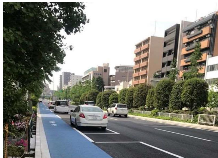
図 4-22 都内における普通自転車専用通行帯の右側に駐車枠を設置した例（白山通り）
