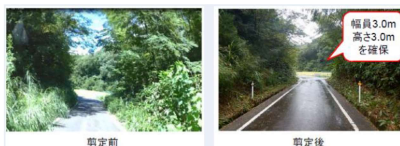
図 3-37 誤検知の原因となる植栽のせん定
