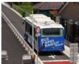
ひたちBRTの事例(茨城県日立市)
