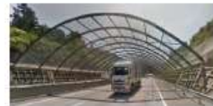
GPS精度低下区間の例(金属ネット)
