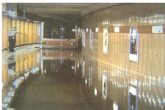
1993（平成 5）年 8 月 27 日台風 11 号による 赤坂見附駅への浸水
