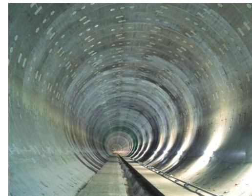
下水道整備（貯留施設）
