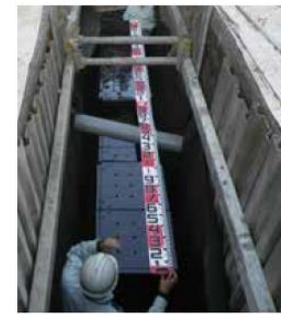
道路下の雨水貯留浸透施設
