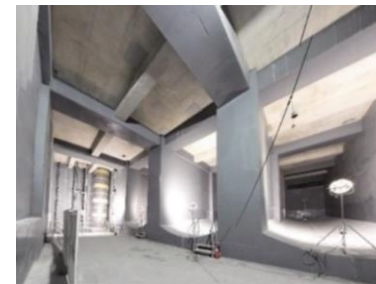
渋谷駅東口地下に整備された雨水貯留施設（再開発との連携）
