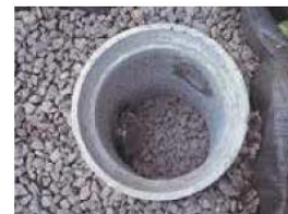
雨水浸透ます
