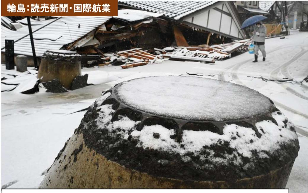
液状化によるマンホールの抜上がり・家屋の沈み込み
