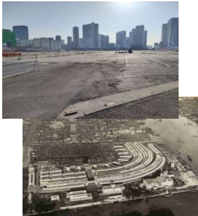
※旧築地市場跡地の現場写真（上段）と築地市場運営時の写真（出典：東京都立中央図書館）（下段）
