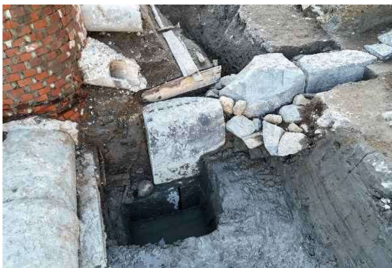
石積 1 検出状況(北東より)
