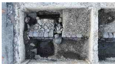
石積2西部(直上より)
