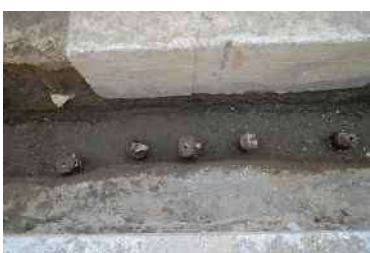
杭列 1 検出状況5(北東より)
