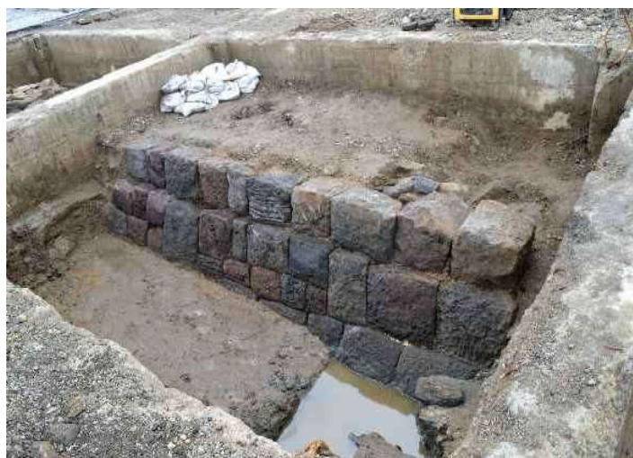
石積2東部断面(東より)
