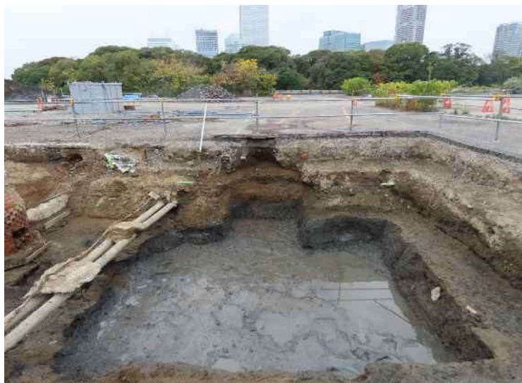
南西部完掘状況(北東より)
