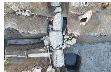
石積 1 検出状況(直上より)
