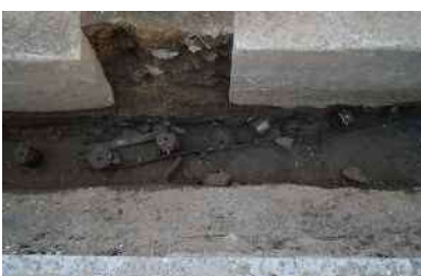
杭列 1 検出状況4(北東より)
