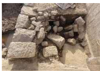
石積2東部石垣石崩落部(直上より)
