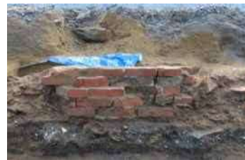
下水枡(煉瓦組)検出状況(北北東より)
