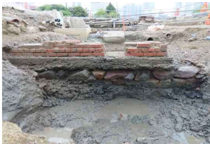
建物基礎(煉瓦組) 4 断面確認状況(北西より)
