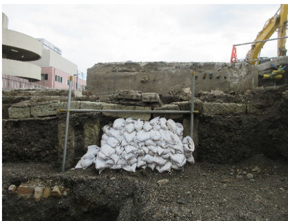
石積5確認状況(北西から)
