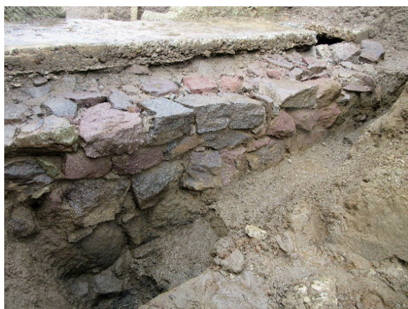
石積7断面確認状況1(南から)
