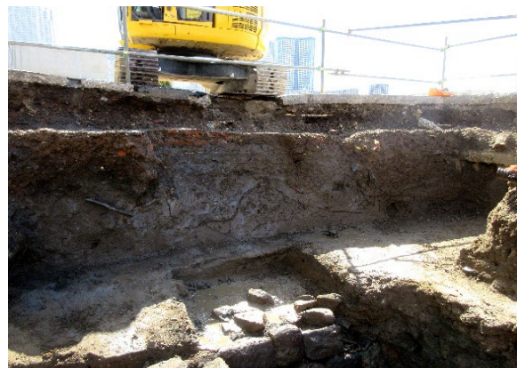
調査区南壁土層観察状況(北から)
