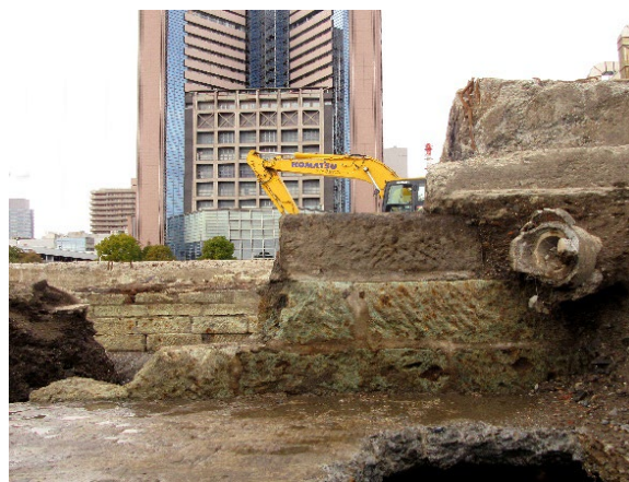
下水溝1・石積8断面確認状況(南東から)
