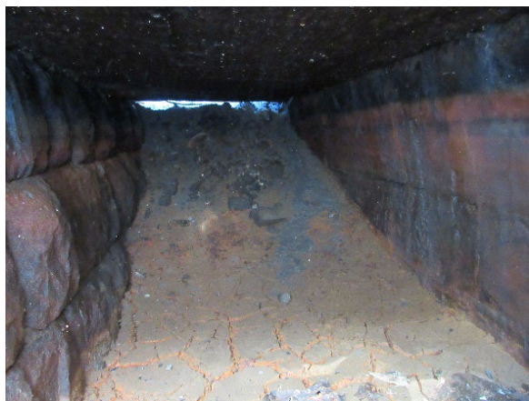
下水溝1内部状況(南壁：石積7、北壁：石積8)
