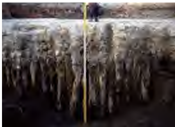
建物基礎（松杭群）検出状況
