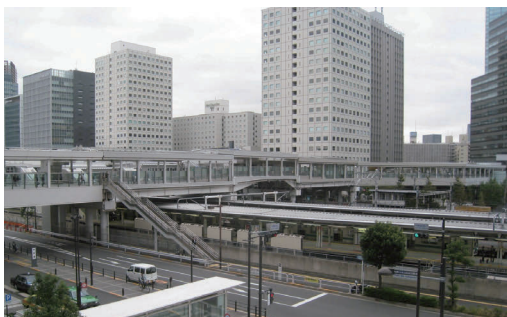
大崎駅東西自由通路 夢さん橋
