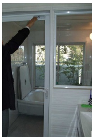
浴室扉上端部への鍵の設置
