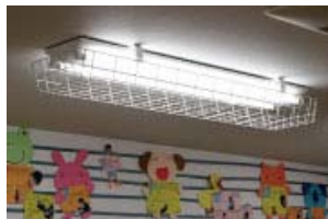
蛍光灯は丈夫なガード付き。中学や高校の子が室内でおもいっきりボール遊びができたらいいなと考えて工夫しました。
