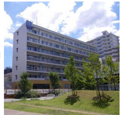
▲ハートアイランド新田四番街建物外観
