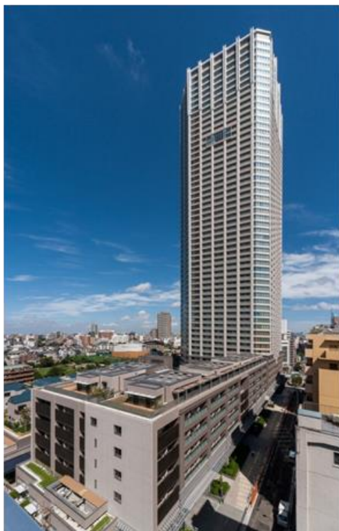
中層棟(グリーンレジデンス)と超高層棟(コンフォートタワー)
