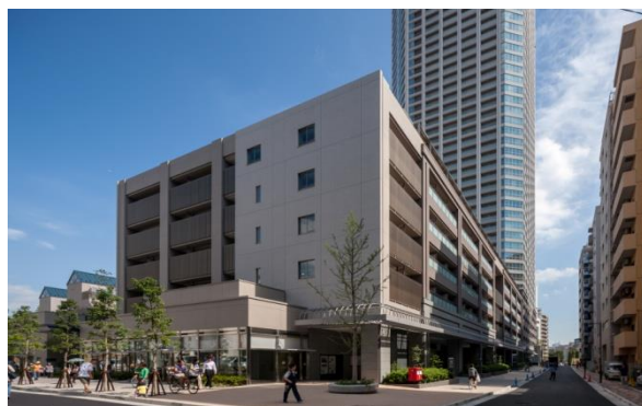
中層棟(グリーンレジデンス)南西側外観
